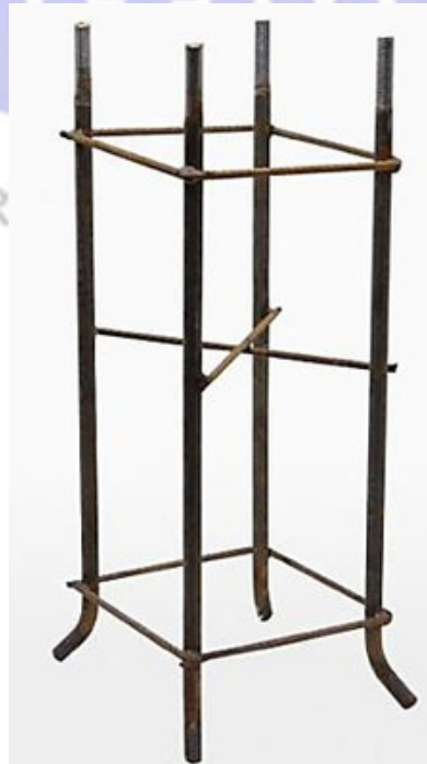
Figura 12.3.1: Pernos de anclaje (Fuente: Elaboración propia).
